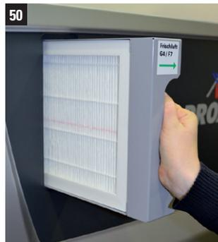
Ziehen Sie die Filtereinschübe nach vorne heraus. Tauschen Sie die Filter aus und entsorgen die verschmutzten Filter im Hausmüll. Achten Sie bitte beim Einsetzen der Filter darauf, dass bei G4-Filtern der
